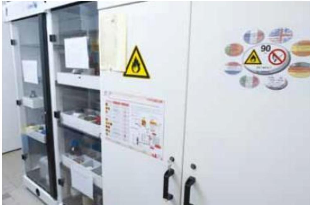
Armoire de stockage ventilée avec rejet de l'air vicié à l'extérieur pour les bouteilles de formaldéhyde et autres produits chimiques
