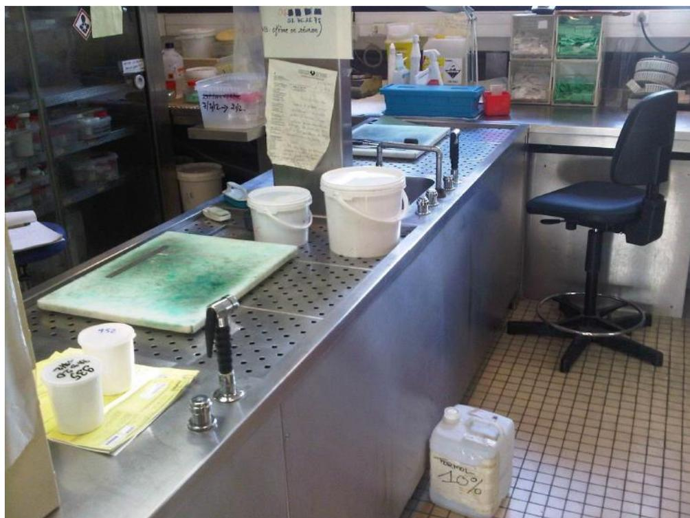
Table aspirante avec obstruction de la table par les objets présents dessus et un encoffrement de la table insuffisant pour un captage efficace
